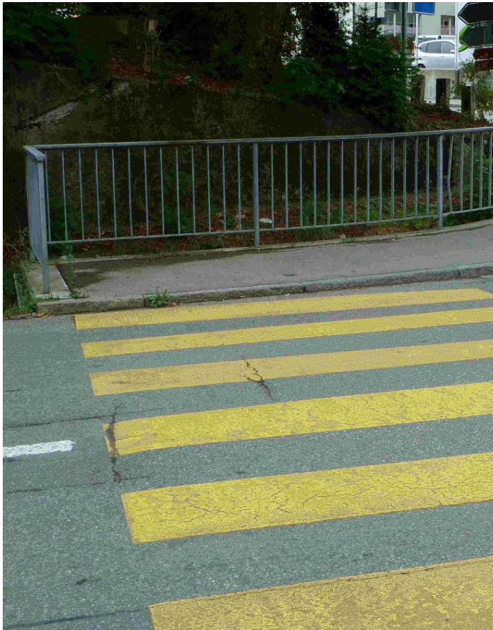
Situation bis zum Baubeginn des Kreisels
